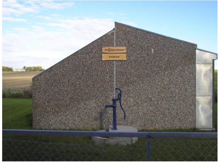
Trykforøgerstation på Valhallavej
